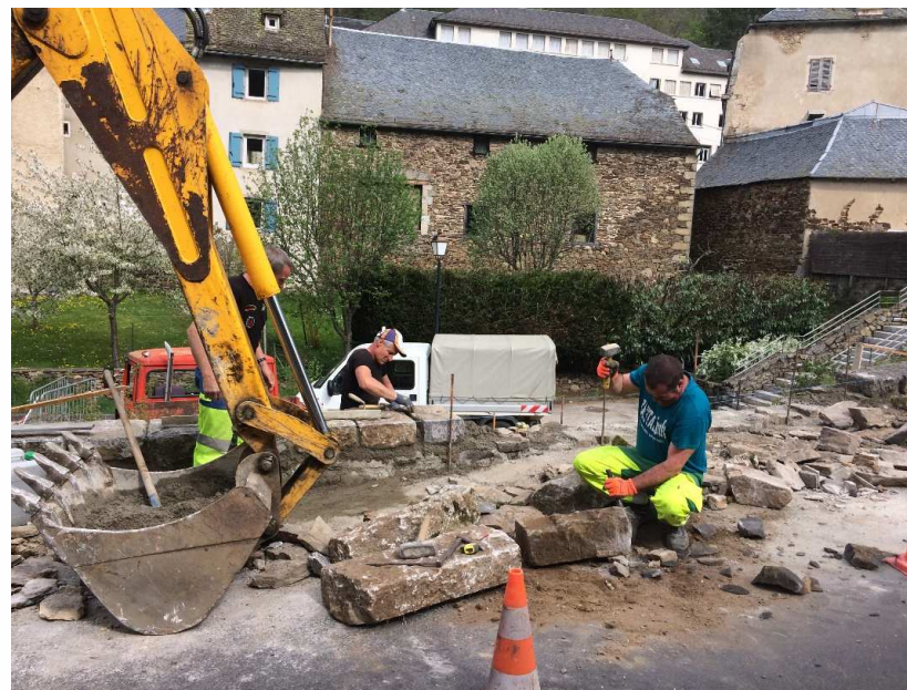
Réfection de mur Commune de Chaudes-Aigues
