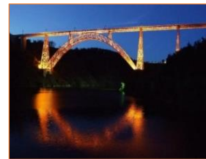
Viaduc de Garabit
